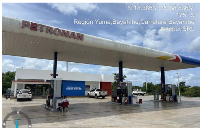
VISTA PANORÁMICA DE LA ESTACIÓN DE SERVICIO
