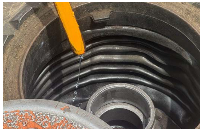
MEDICIÓN Y CORTE DE AGUA LIBRE EN LOS TANQUES DE ALMACENAMIENTO
