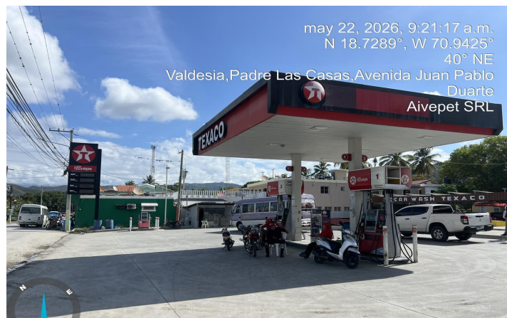
VISTA PANORÁMICA DE LA ESTACIÓN DE SERVICIO
