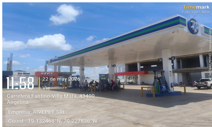
VISTA PANORÁMICA DE LA ESTACIÓN DE SERVICIO
