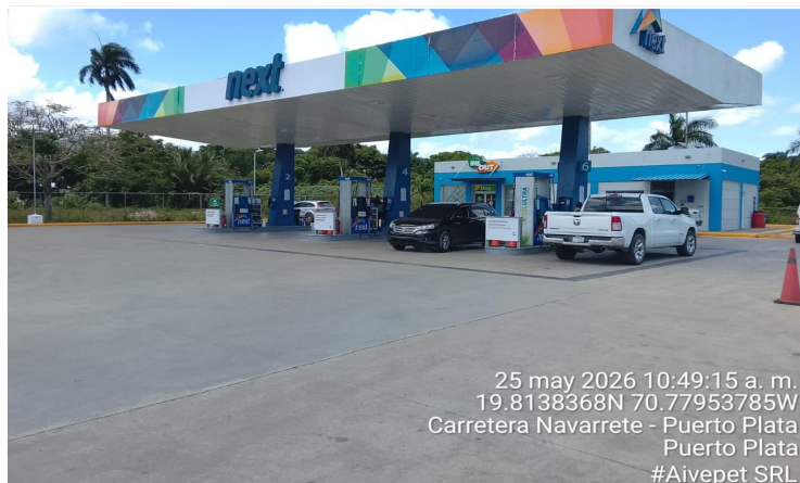
VISTA PANORÁMICA DE LA ESTACIÓN DE SERVICIO
