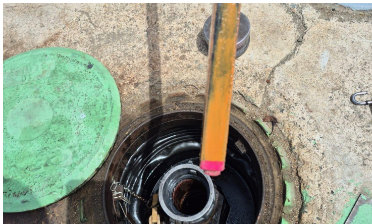
MEDICIÓN Y CORTE DE AGUA LIBRE EN LOS TANQUES DE ALMACENAMIENTO
