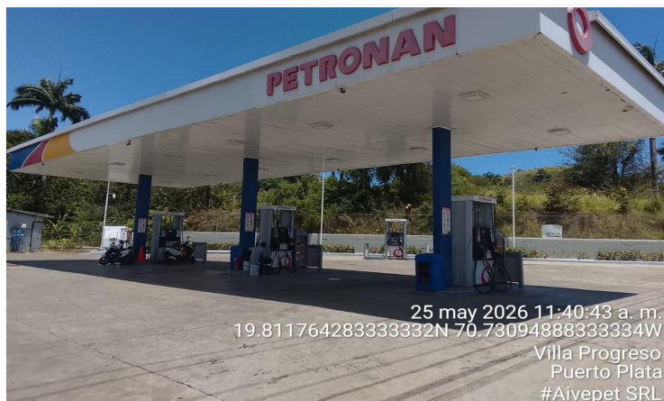
VISTA PANORÁMICA DE LA ESTACIÓN DE SERVICIO
