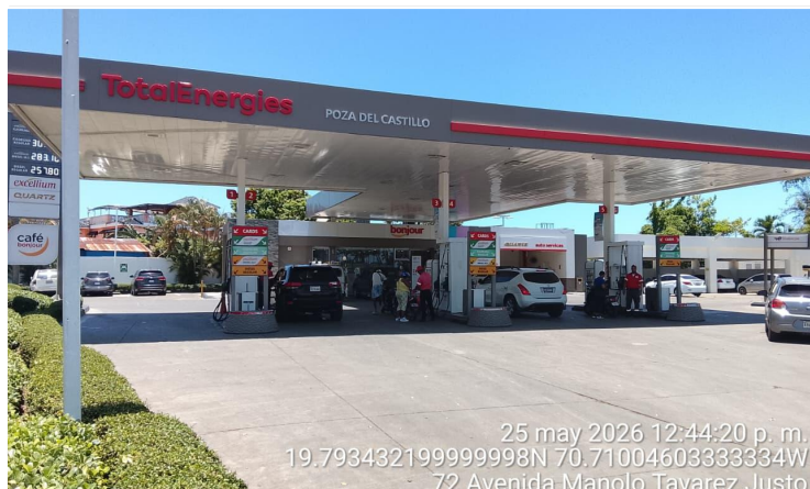
VISTA PANORÁMICA DE LA ESTACIÓN DE SERVICIO
