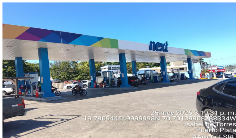
VISTA PANORÁMICA DE LA ESTACIÓN DE SERVICIO
