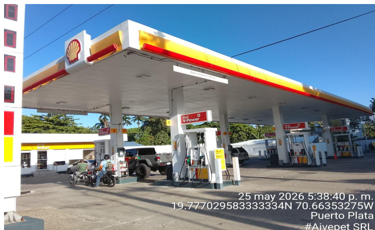
VISTA PANORÁMICA DE LA ESTACIÓN DE SERVICIO
