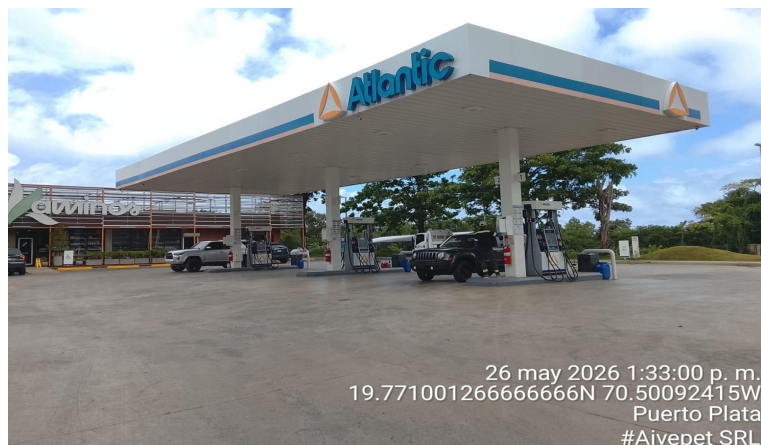
VISTA PANORÁMICA DE LA ESTACIÓN DE SERVICIO
