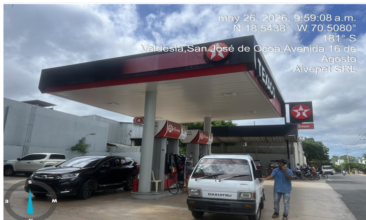
VISTA PANORÁMICA DE LA ESTACIÓN DE SERVICIO
