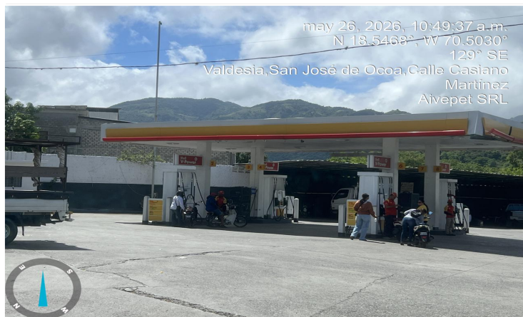
VISTA PANORÁMICA DE LA ESTACIÓN DE SERVICIO
