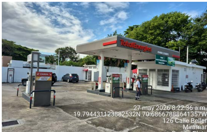
VISTA PANORÁMICA DE LA ESTACIÓN DE SERVICIO
