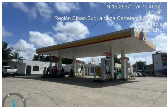
VISTA PANORÁMICA DE LA ESTACIÓN DE SERVICIO
