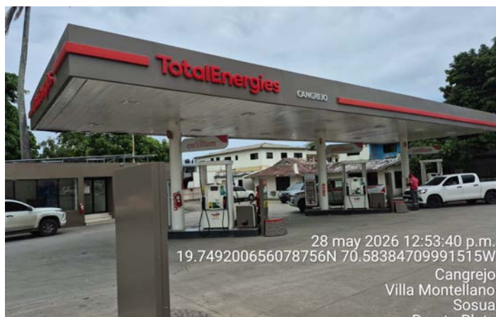
VISTA PANORÁMICA DE LA ESTACIÓN DE SERVICIO
