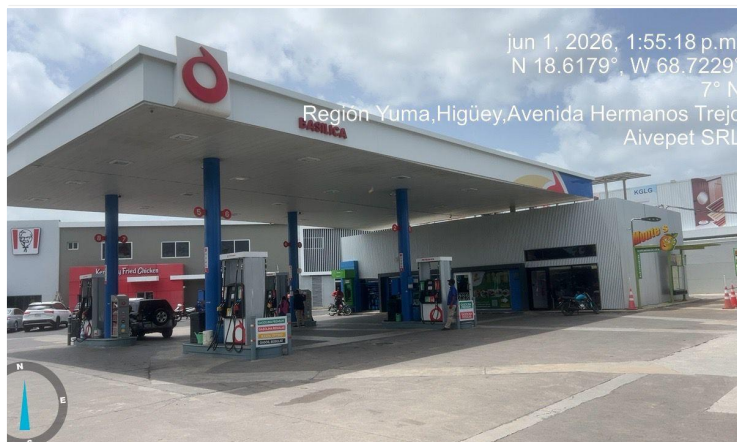
VISTA PANORÁMICA DE LA ESTACIÓN DE SERVICIO
