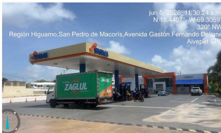
VISTA PANORÁMICA DE LA ESTACIÓN DE SERVICIO
